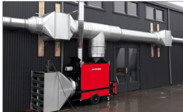
**JUMBO - INDIRECT COMBUSTION HEAVY DUTY MOBILE SPACE HEATERS
